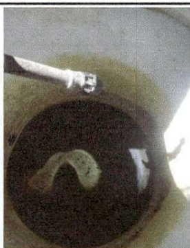
Foto 3: Cambio de depósito de Agua
