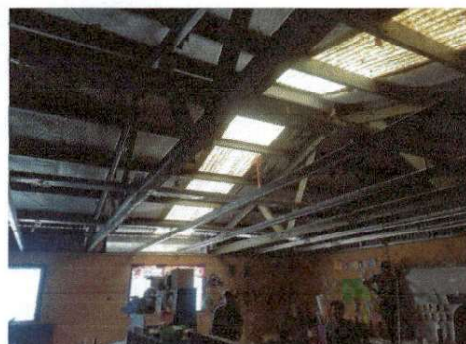
Foto 4: Colocación de cielo falso de PVC
