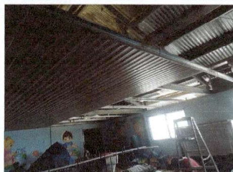
Foto 6: Colocación de cielo falso de PVC
