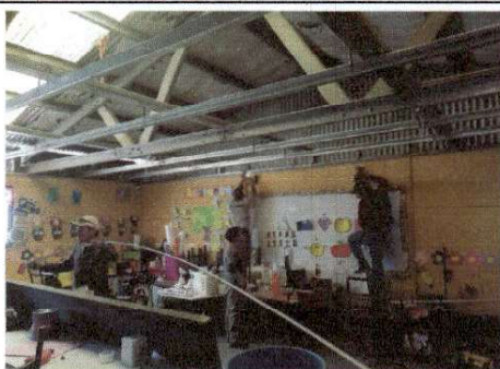
Foto 5: Colocación de cielo falso de PVC
