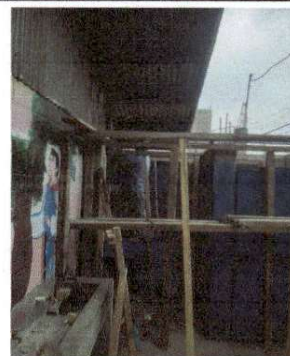
Foto 2: Cambio de lamina por losa en modulo de baños.
