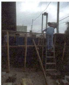
Foto 1: Cambio de lamina por losa en modulo de baños.
